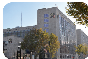
Reforma Edificios "Campos Velázquez". Madrid.
