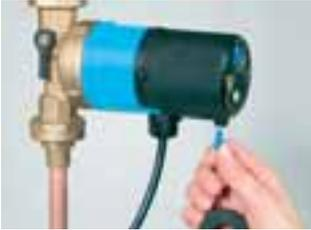
Conecte la clavija del cable del sensor en la bomba.
